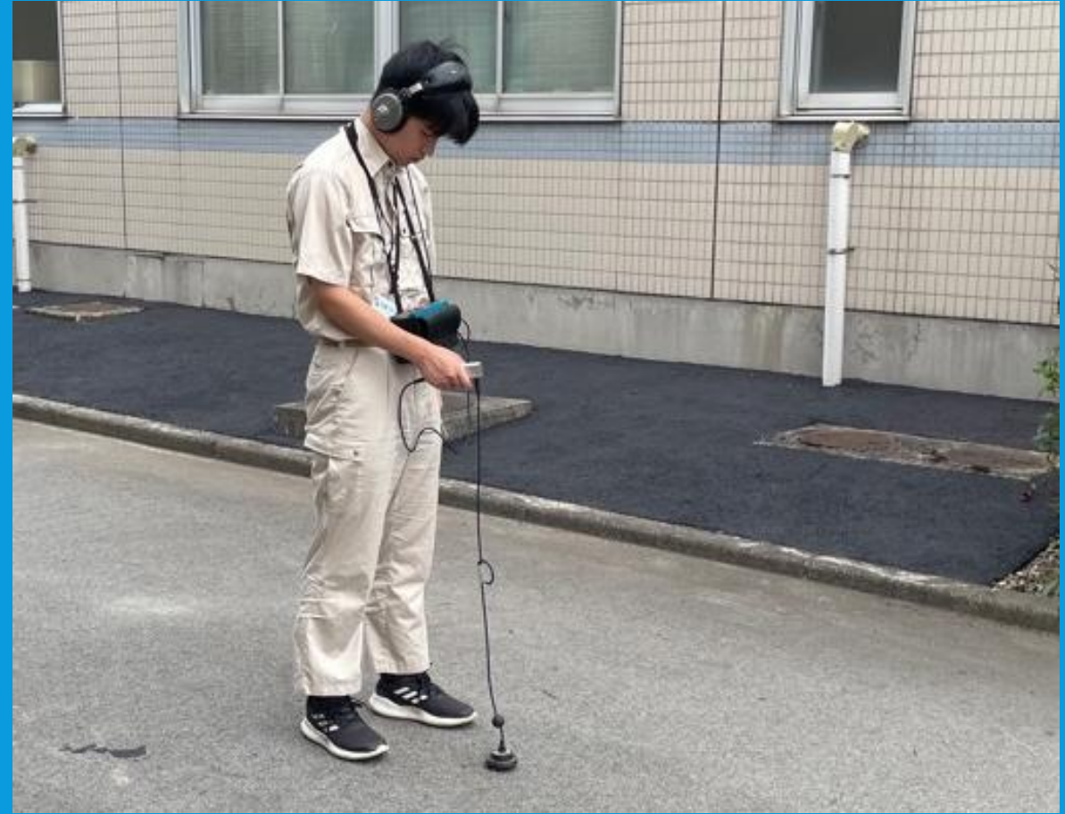
漏水調査 (音聴による現場調査)
