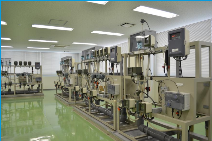
24時間水質監視（各工程の水質）
