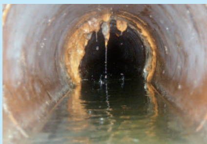
管きょの亀裂より内部に浸入する地下水
