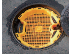
鉄蓋交換、高さ調整状況
