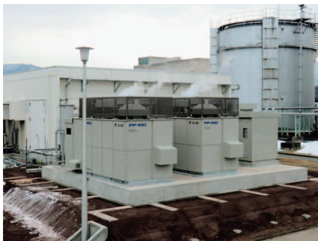
浄化センターに設置した新型燃料電池(平成24年度設置)
