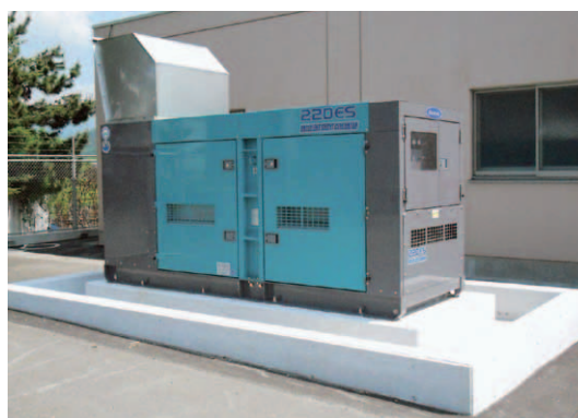
新設した立谷川増圧ポンプ場の発電機
