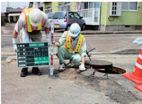
5月16日～22日 多賀城市での 下水道管きよ被害調査
