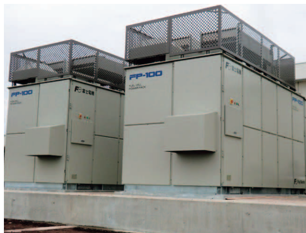
浄化センターに設置した新型燃料電池(平成24年度設置)
