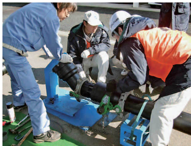
配管接合実地研修
