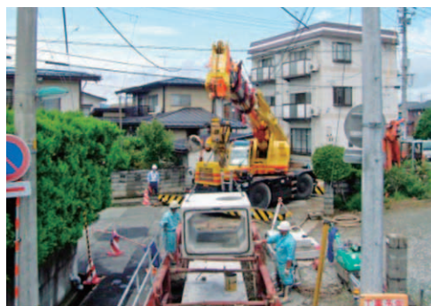
浸水対策工事施工状況
