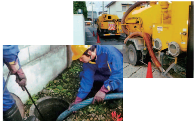
下水道管きょ等の清掃及びしゅんせつ作業状況
