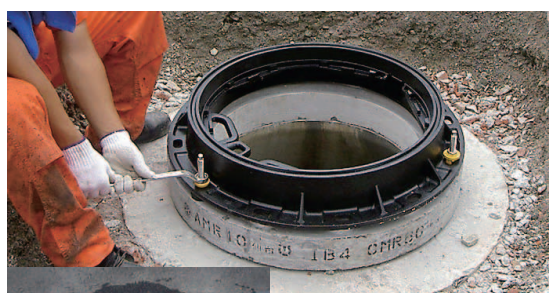
鉄蓋交換、高さ調整状況
