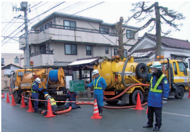
下水道管きょ等の清掃及びしゅんせつ作業状況
