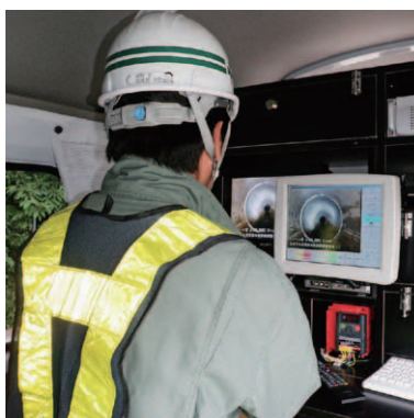
テレビカメラによる管きょ調査状況と内部映像
