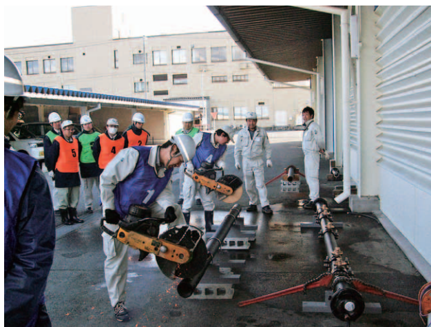
エンジンカッターによる水道管切断研修
