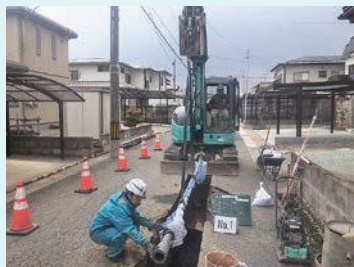
地震に強い耐震管で更新
