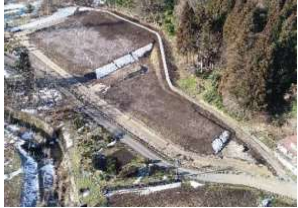
工事進捗状況(造成工事)令和8年2月撮影
