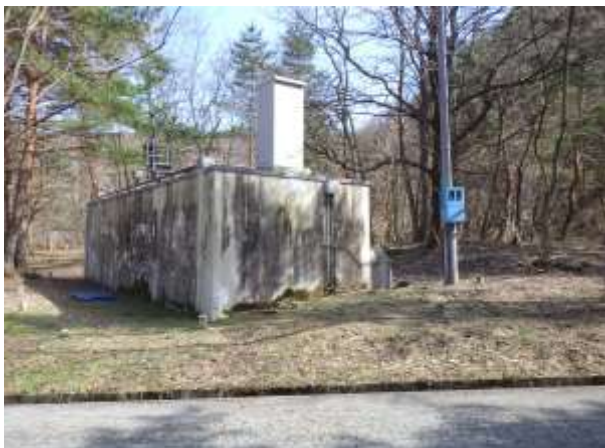
既設蔵王ダム量水井
