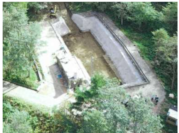
工事進捗状況(造成工事)令和7年10月撮影
