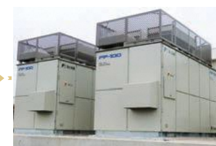
排熱利用 100kW 燃料電池発電装置(4台)
