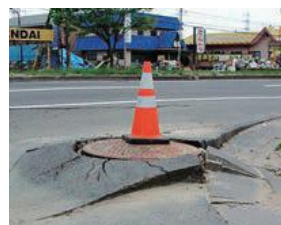
東日本大震災の揺れにより浮上したマンホール(宮城県多賀城市)
