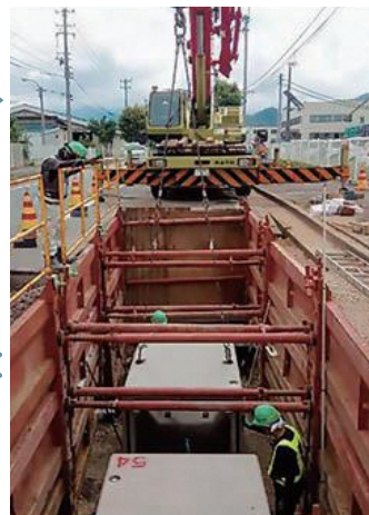
整備中 道路下に大断面（900mm～2500mm）の雨水管（ボックスカルバート）などを埋設し排水機能を強化
