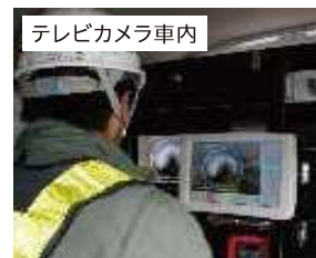
モニターで管きょ内調査中
