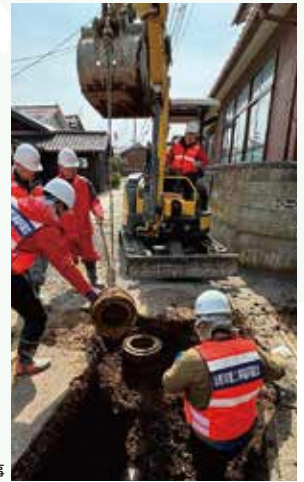
漏水修繕工事
