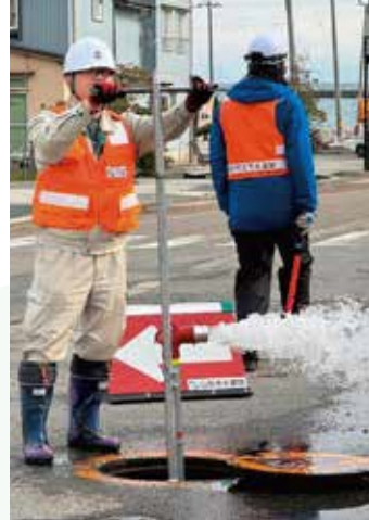
水道管通水作業(石川県珠洲市)
