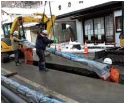
耐震管入替工事(山寺地区)
