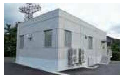
小水力発電施設(松原浄水場)
