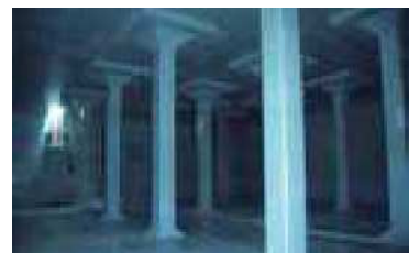
南山形配水場の耐震補強工事
