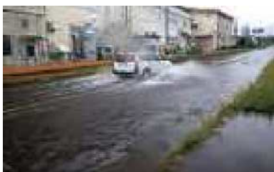
整備前 大雨時に道路冠水
