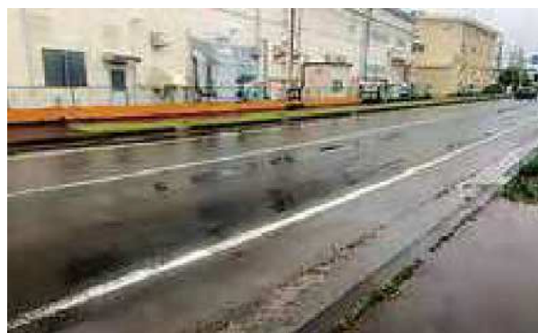
整備後 道路冠水が軽減
