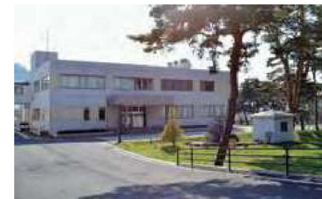
全面改築された松原浄水場
