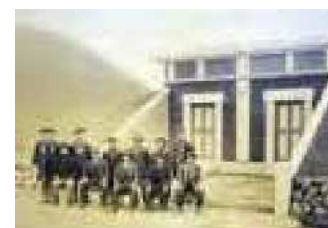
通水当初の配水場
