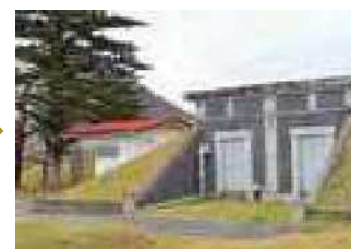
現在の松原配水場
