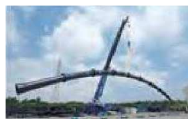
つなぎ目が鎖のように動く耐震管
