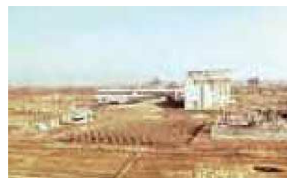
建設中の見崎浄水場
