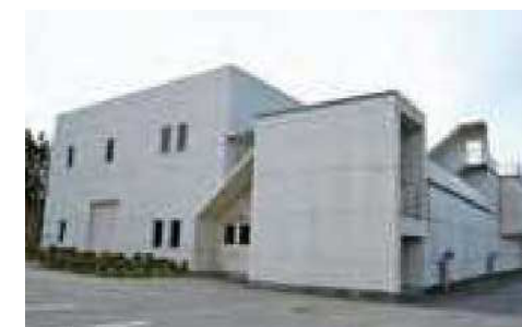
高度浄水処理施設(見崎浄水場)
