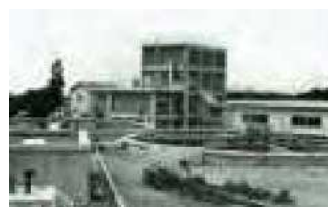
建設中の松原浄水場
