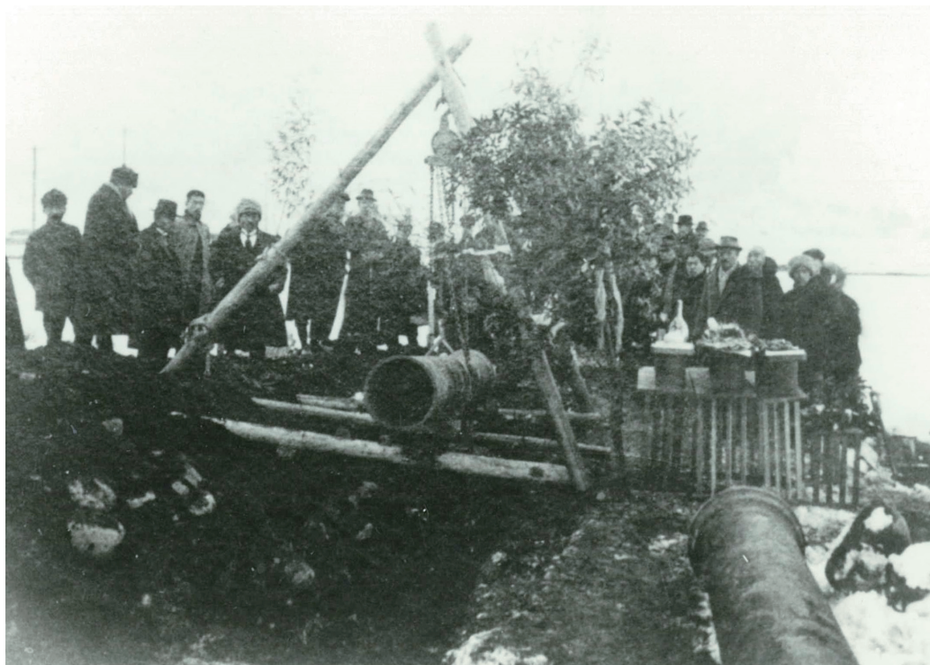
水道主管埋立地鎮祭 大正7年頃
