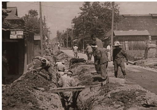
松原浄水場 水道管布設工事 大正9年頃～昭和初期
