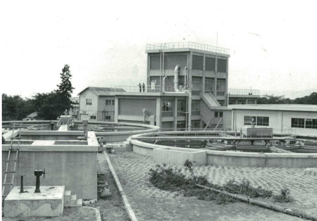
旧松原浄水場管理棟と高速凝集沈殿池（蔵王ダムからの原水を処理する施設）
