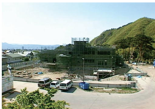
松原浄水場新築整備事業 平成13年～平成18年
