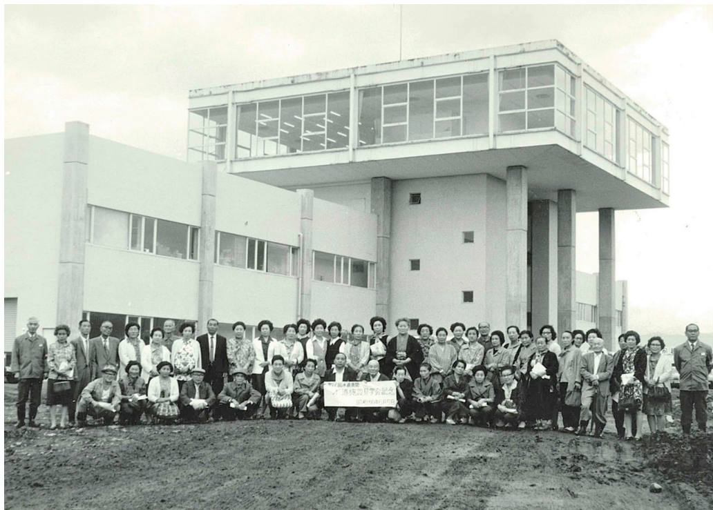
施設見学（見崎浄水場 第一期工事完成後）昭和50年
