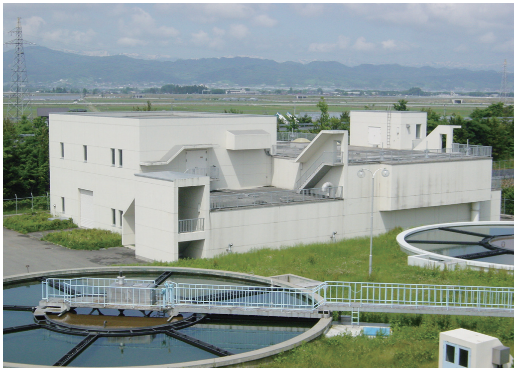
見崎浄水場高度浄水処理施設 平成9年完成
