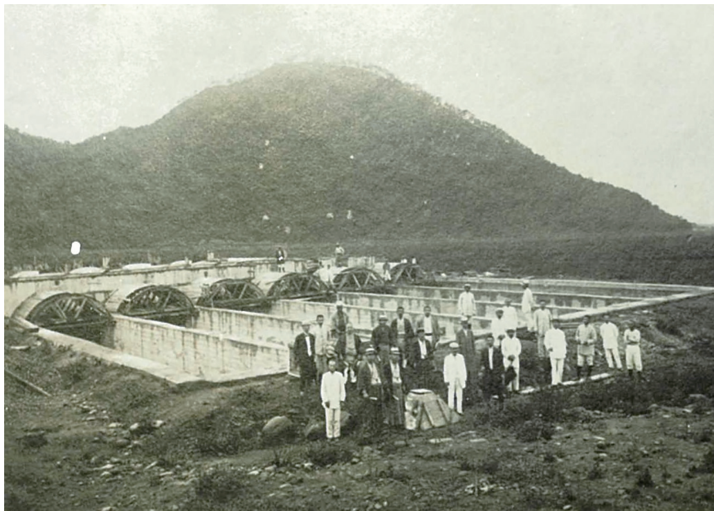
配水池の工事（現松原配水場）大正8年～9年 市会議員一行貯水池視察
