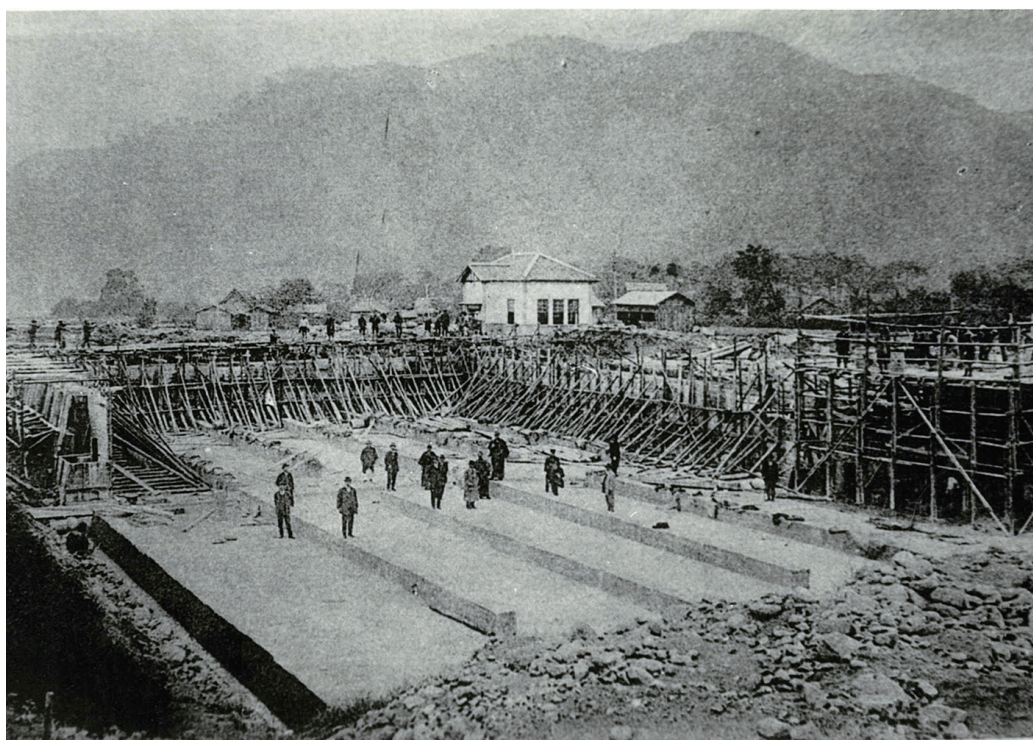
配水池の工事（現松原配水場）大正10年～11年頃
