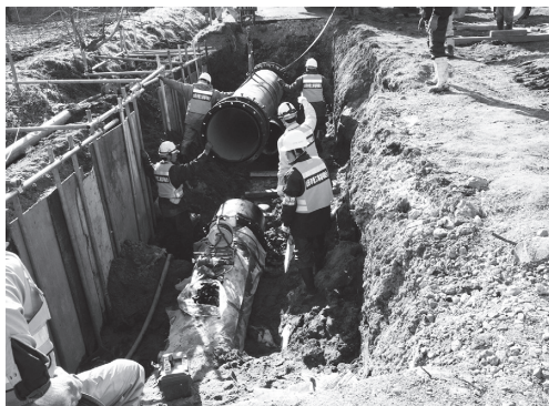
災害派遣応急復旧作業
