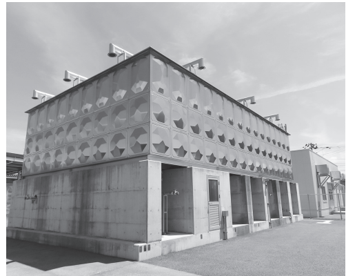
南石関ポンプ施設
