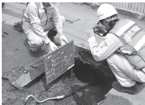
熊本地震 漏水調査（上）・修理作業（下）
