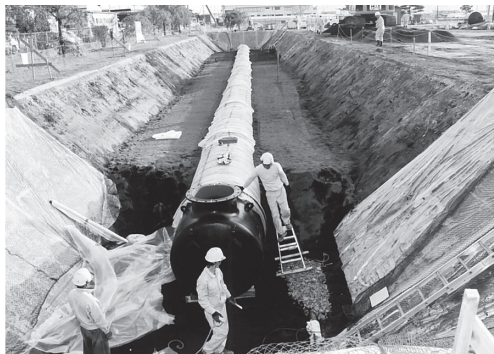
管理センター第3ロット緊急貯水槽設置工事
