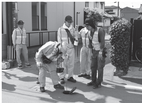
熊本地震 漏水調査（上）・修理作業（下）
