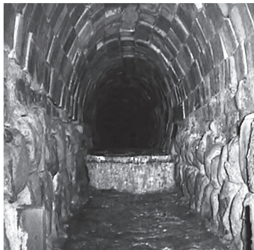
松原浄水場にある横坑
