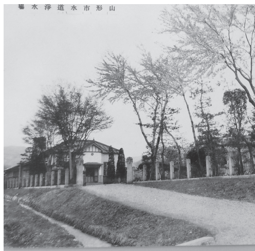
完成した山形市水道浄水場
