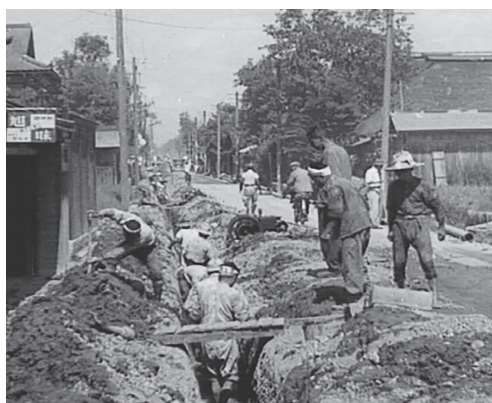
配水管布設工事（昭和10年頃）
