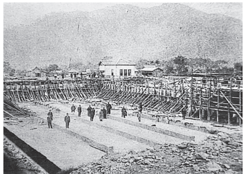
山形市浄水場建設現場（大正11年）
