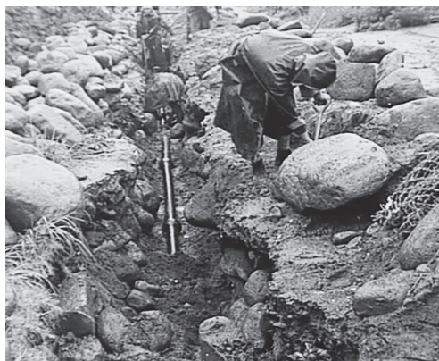
山形市浄水場付近の配水管布設工事
