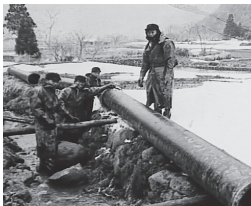
山形市浄水場建設工事
