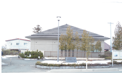
七浦中継ポンプ場 (山形市大字七浦)
