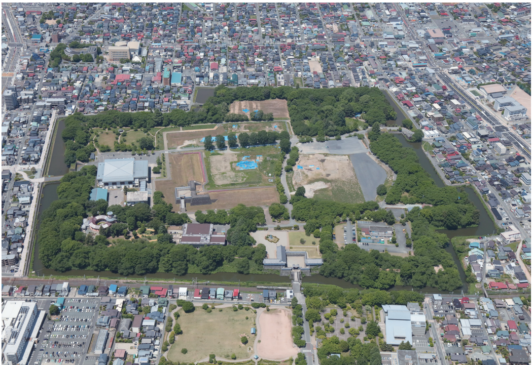
写真中央が山形城址の霞城公園で公園手前入口が東大手門 (山形市総務部広報課提供)
