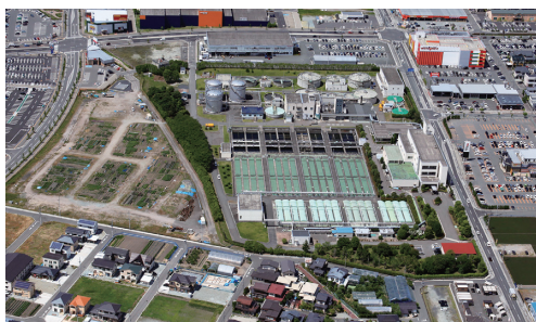
山形市浄化センター (山形市嶋南)
