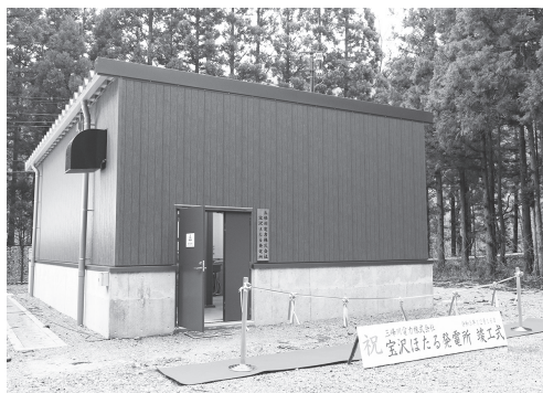
「宝沢はたる発電所」外観
