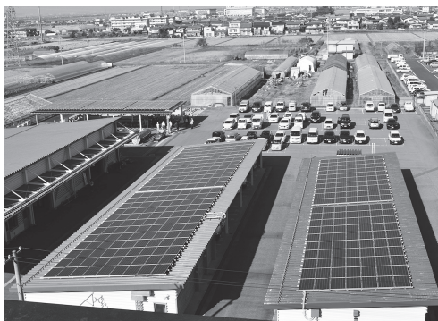
車庫と研修施設に設置された太陽光発電パネル
