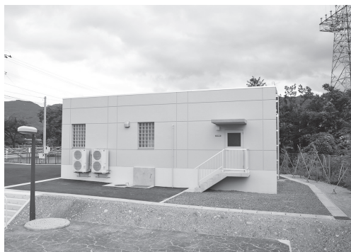
松原浄水場 小水力発電施設
