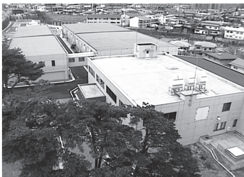
新松原浄水場全景
