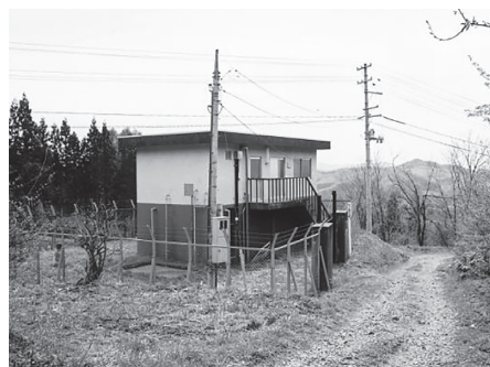
蔵王堀田浄水場
