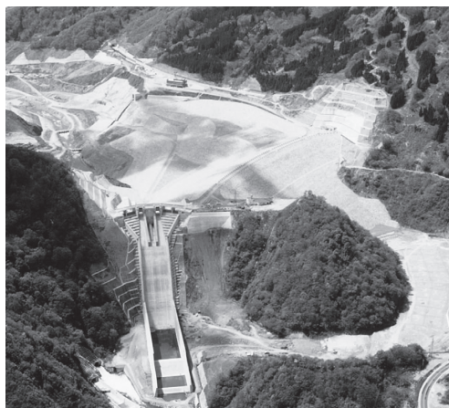
建設中の寒河江ダム
