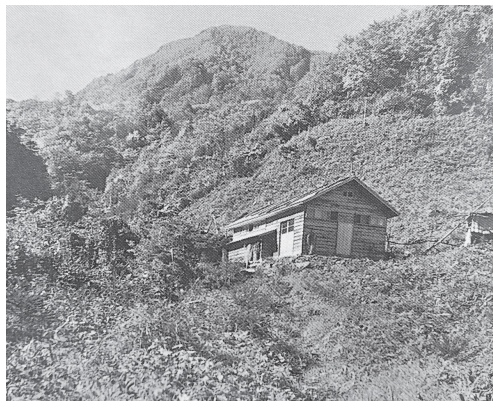
建設当時の管理小屋
