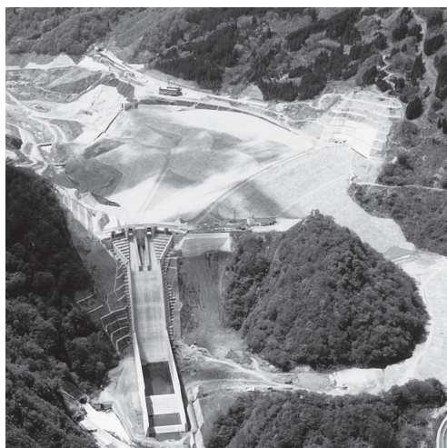
建設中の寒河江ダム
