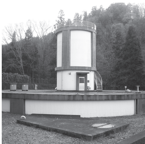
鈴川配水場 配水池 高区(2階)・低区(1階)
