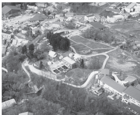
蔵王温泉浄水場
