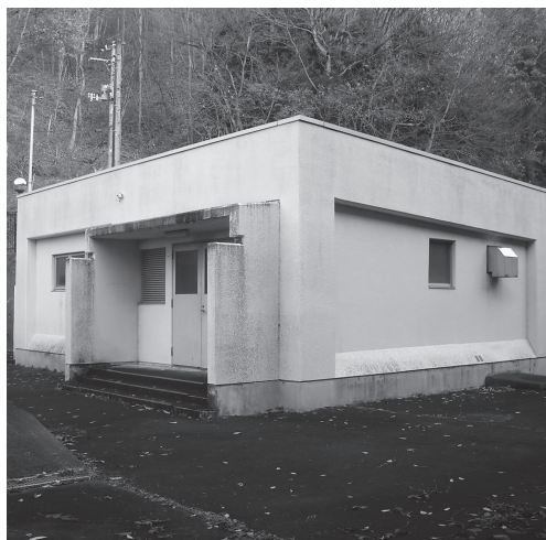
鈴川配水場電気計装室
