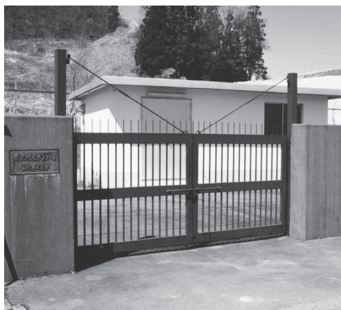
菅沢増圧ポンプ場
