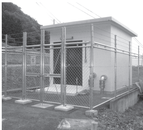
岩波第二ポンプ場
