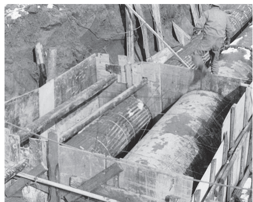
口径800mm導水管 1200mm配水本管布設工事
