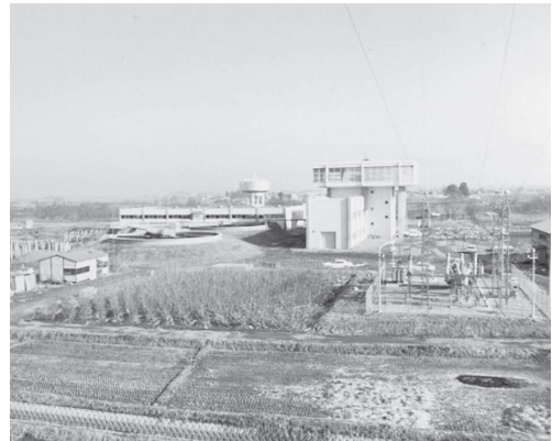
建設中の見崎浄水場
