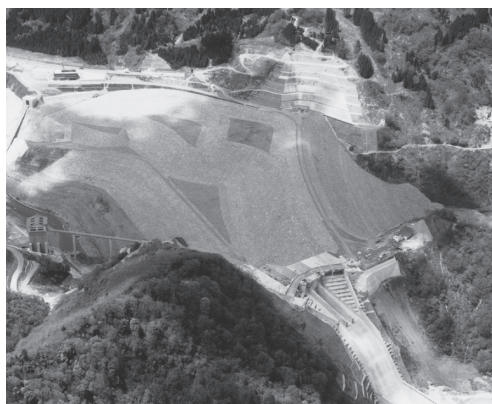
建設が始まった寒河江ダム
