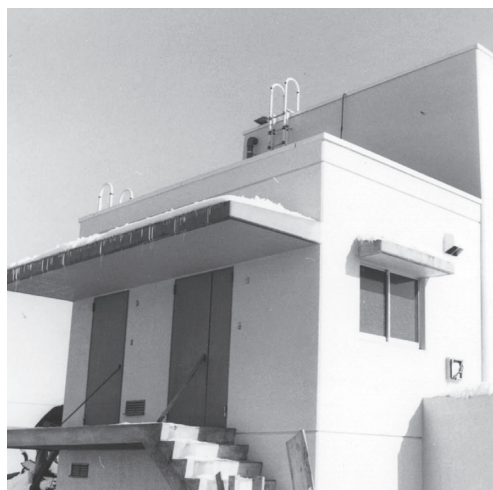
小松原配水場
