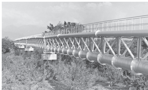
見崎浄水場につながる須川水管橋
