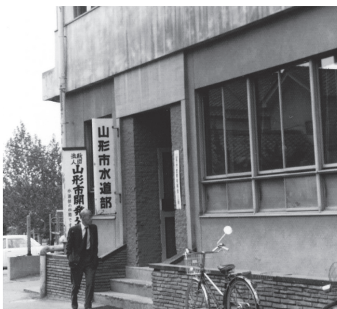
旧市役所庁舎 山形市水道部
