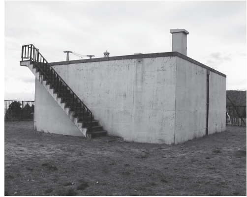
蔵王山田第二配水池
