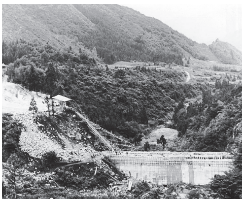
不動沢ダムの建設現場
