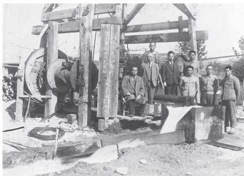
宮町薬師裏水源鑿泉（第四水源）
