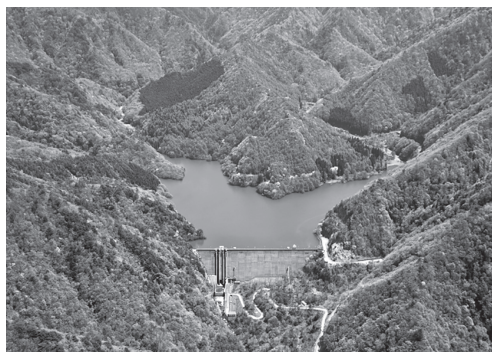
蔵王ダム全景
