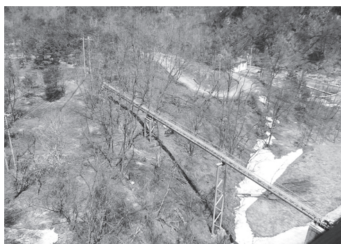
蔵王ダム導水管
