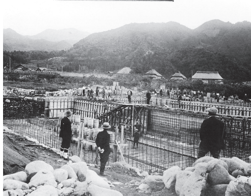
新設される濾過池工事（大正15年）
