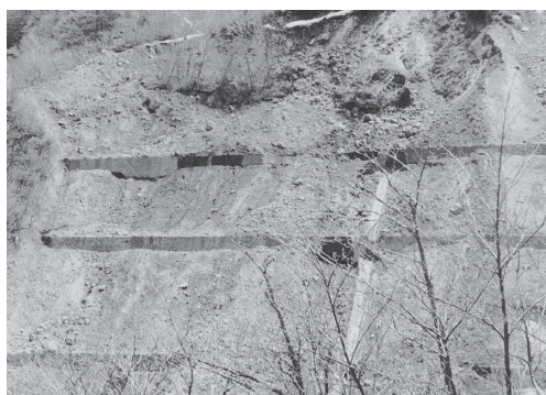
ナへ沢の山腹工事
