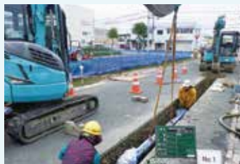
地震に強い耐震管で更新
