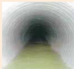
更生工事を行った汚水管内部
