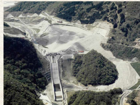
寒河江ダム (建設中) (昭和50年代)
