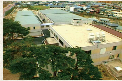
松原浄水場新築整備事業 (平成18年)
