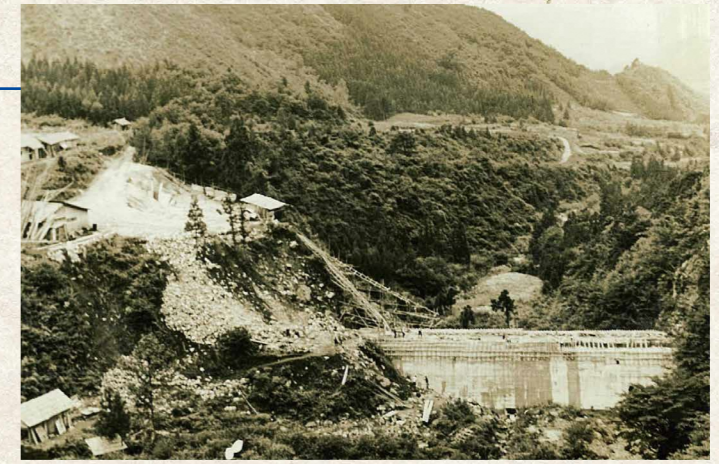
不動沢ダム建設 (昭和27年頃)
