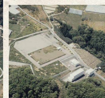
南山形配水場 (平成元年)
