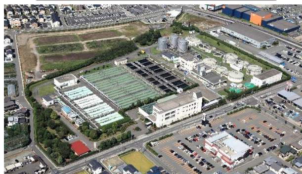
【山形市浄化センター】
