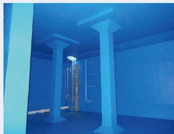
耐震補強を行った配水池内部
