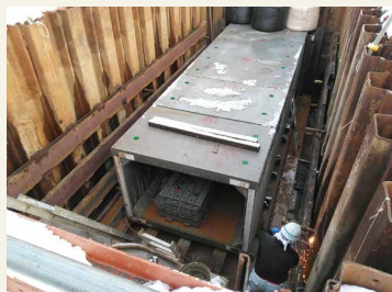
道路下への雨水管設置工事
