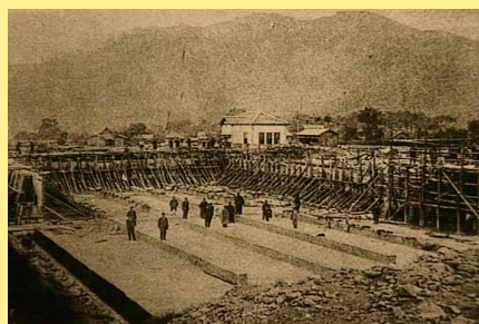
松原浄水場築造工事
