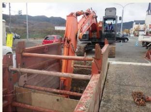
松波三丁目、立谷川二丁目など9工区で、約1,100mの雨水管整備を行いました。本工事により、大雨や集中豪雨などによる浸水被害を防ぐことができます。
