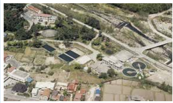
昭和41年から平成17年の間の松原浄水場
