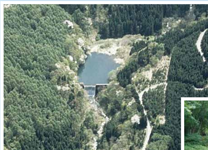
平成6年に撮影した不動沢ダムの全景です。
