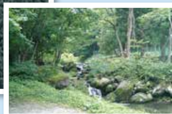
不動沢取水場
