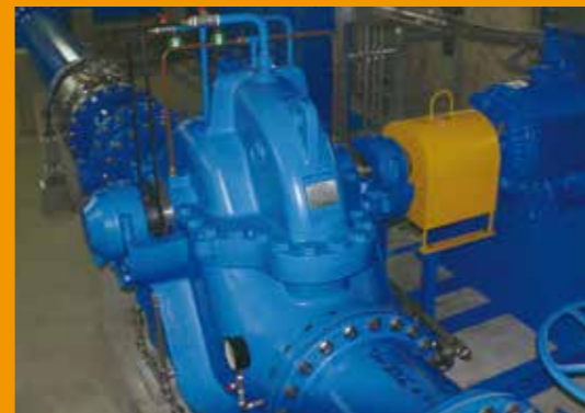
流れてきた圧力水を水車で回転力に変えます。
