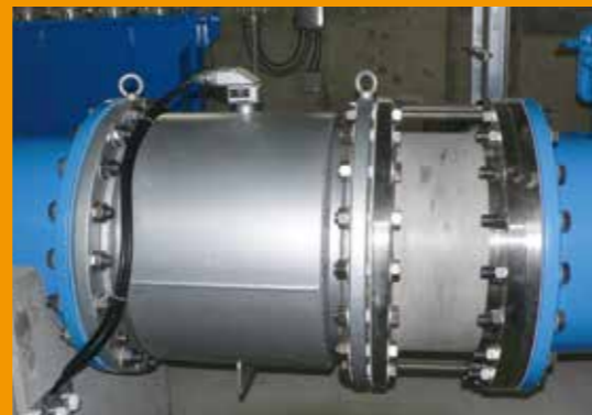
水車に流れる水量を正確に測定します。
