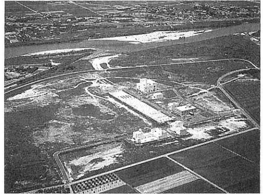
流域浄化センター全景
