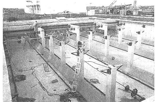
沈殿池設置工事
