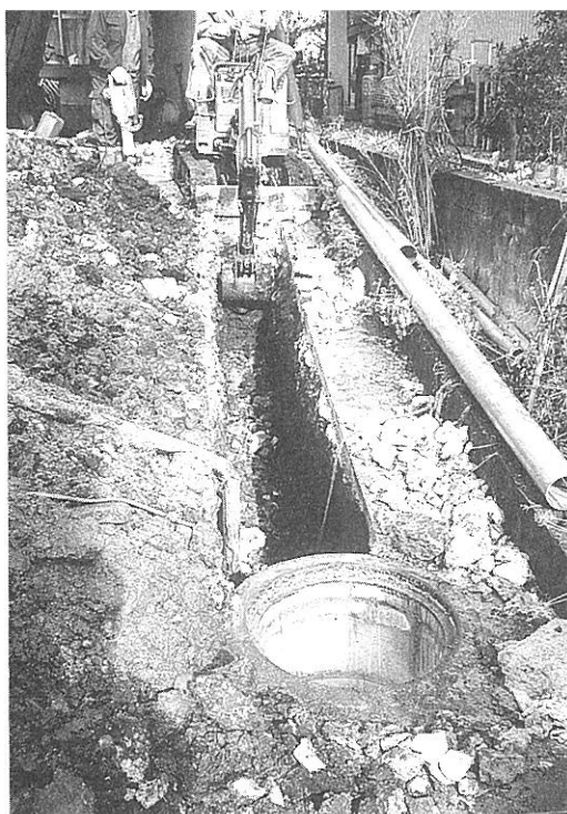
排水設備工事
