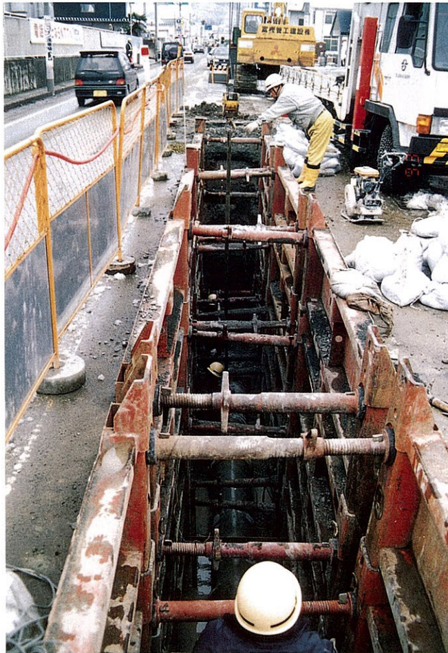
南二番町汚水管渠埋設工事
