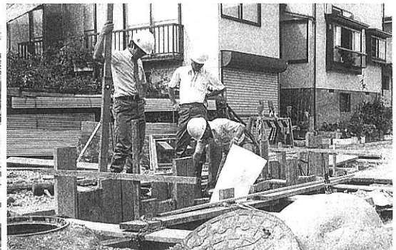
宮町汚水工事
