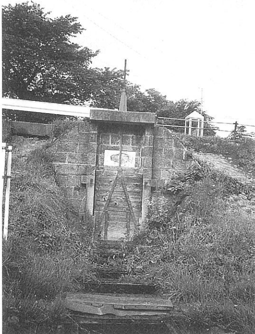
宮町堰取入口 (大正4年水門工事)
