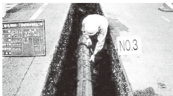
老朽配水管の更新工事
