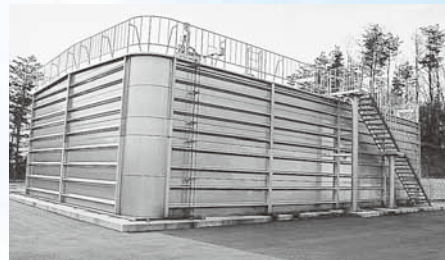
耐震化された配水池
