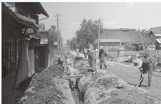
昭和28年当時の配水管布設工事
