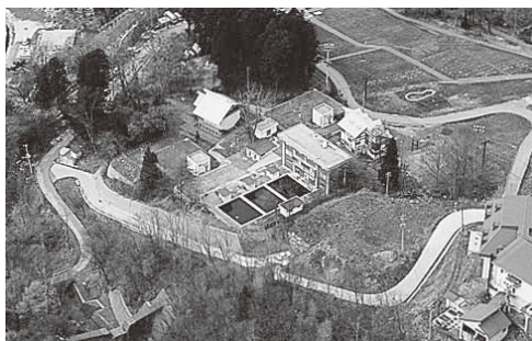
蔵王温泉浄水場
