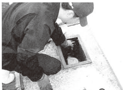
山形市水道サービスセンターによる メーター取替の様子
